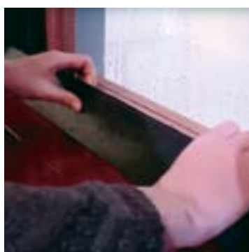
Het afneembaar profiel wordt makkelijk opengeklikt
