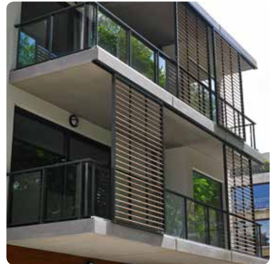
Loggiawood®, Sous Chavort, Appartements, Montmélian (FR)
