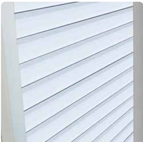
Lamellen kunnen manueel gekanteld worden van gesloten naar volledig open positie
