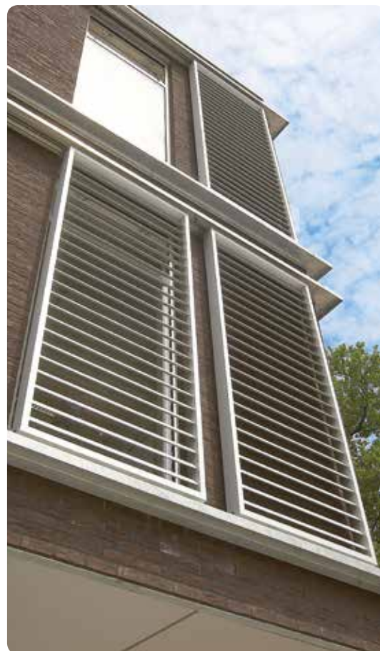
Loggia® LG.130 met ICA.125, Campus KaSo, School, Maaseik (BE)
